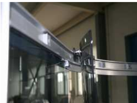
B-7.Peale rullikute paigaldamist asetage klaas uks selleks ettenähtud soonde
