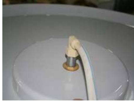
B-20. Vee ühendus koht lae dussile
