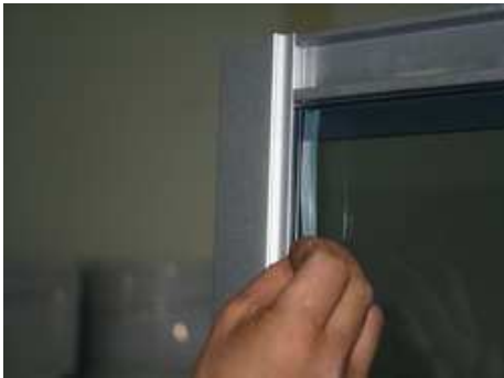
B-11.suruge tihend klaasi ja raami vahele nagu näidatud
