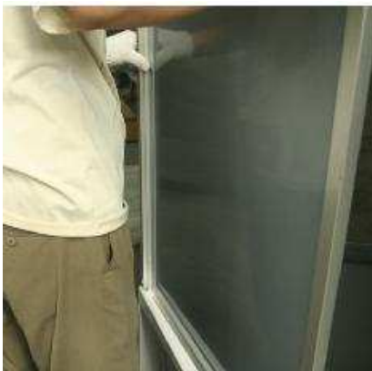
B-13. Asetage tagumine klaas nagu näidatud
