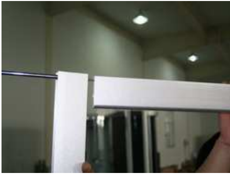
B-1.ühendage kaares raamid sirgetega, Kinnitage kruvidega (4*60 polt )
